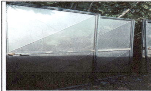
FOTO 9: Fabricación e instalación de puertas de metal en módulos
