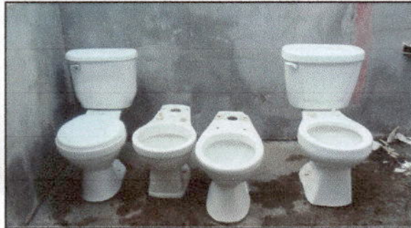
FOTO 1: Sustitución de inodoro
