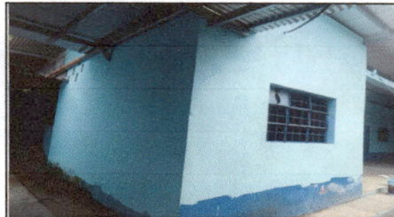
FOTO 10: Pintura en muros exteriores e interiores
