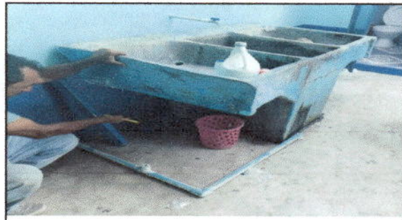
FOTO 6: SUSTITUCION DE PILA DE DOS LAVADEROS
