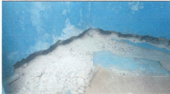
FOTO 3: SUSTITUCION DE TUBERIA LINEA PRINCIPAL
